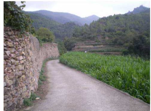
El último tramo, será entre huertas y por camino asfaltado
