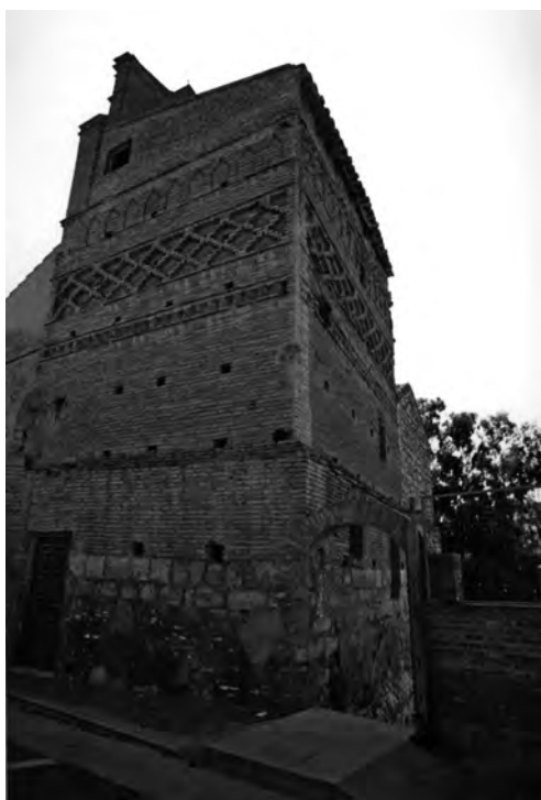
Fig. 5. Torre de la parroquia de San Blas de Ribaforada (M.J. Tarifa).
