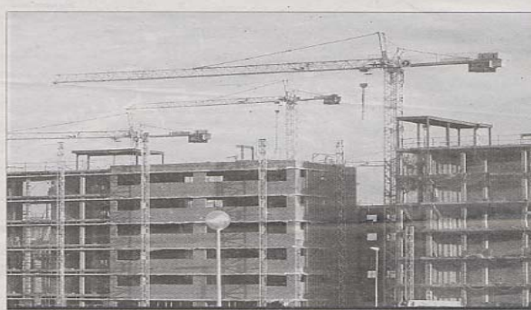
Obras de construcción de viviendas en San Chinarro, en la zona norte de Madrid.
