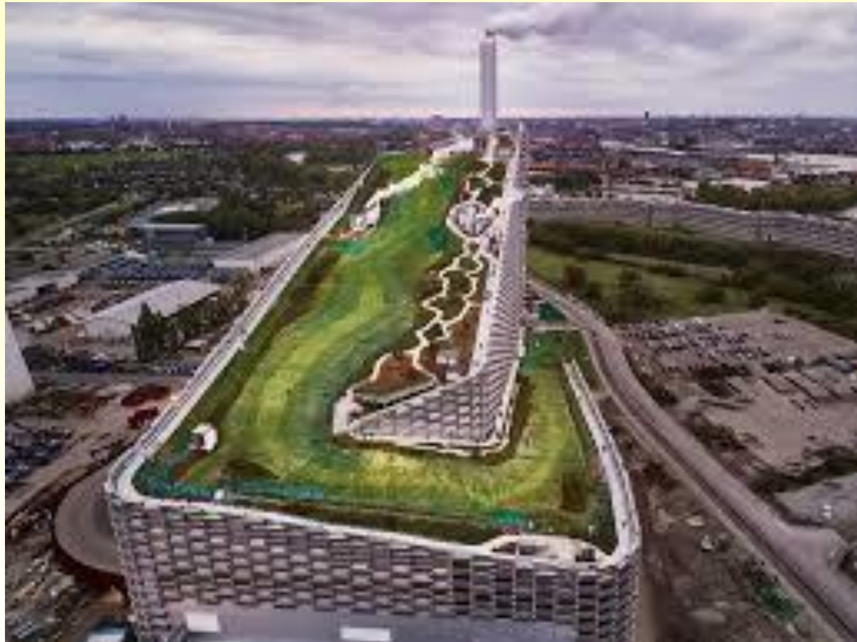
Planta de valorización energética de Copenhague (Dinamarca)
